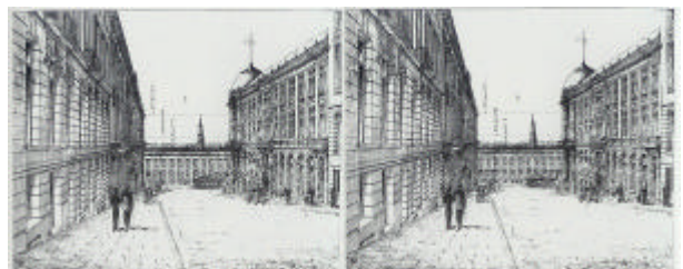
図 6 Passage de la Bibliothèque からの眺望シミュレーション
