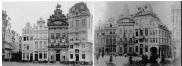
写真2 (左)星の館再建前、(右)再建後 再建前の写真右端の建物が「白鳥の館」であり、道路沿いの壁面が全てむき出しになっている。
