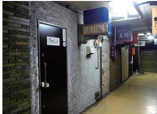
図 5-2 内部通路の表層
