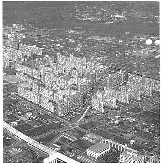
図4 高島平団地と周辺の空地 （『日本住宅公団20年史』、日本住宅公団、1975年）
