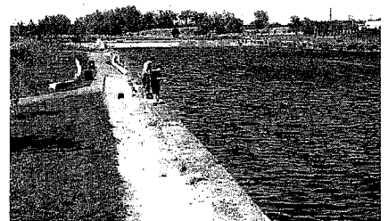
写真1 LCP 中央の港湾施設を転用した公園 (筆者撮影)
