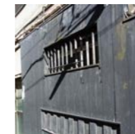
木製格子窓を持つ建築物の例
