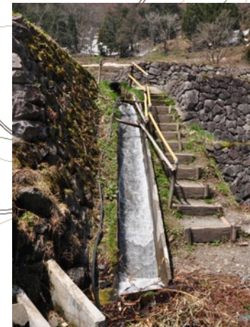
U字溝となっている水路
