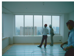
▲芝浦アイランド・現場見学 (筒井)
