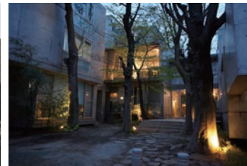
▲既存樹を囲む羽根木の住棟
