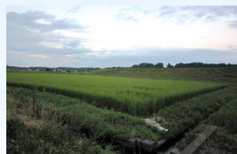
▲堤防の不連続部分
