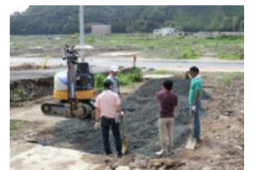
▲隣の建設会社の方がパワーショベルを出して下さいました
