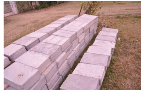
▲LDTが準備していたコンクリートブロック
