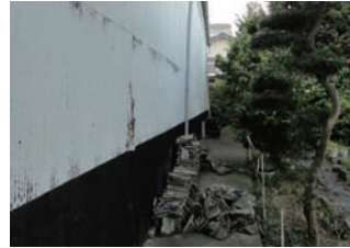
▲地震の影響で崩壊した瓦
