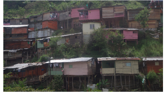
▲メデジン市 Sant Javier 地区。崖地につくられた不良住宅
