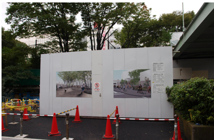
▲工事用仮囲いに覆われた宮下公園
