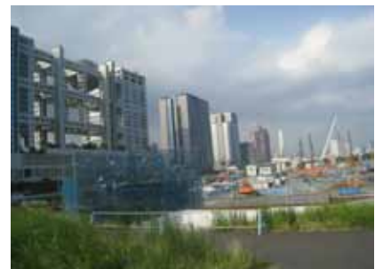
▲隣接地の複合ビル建設現場
