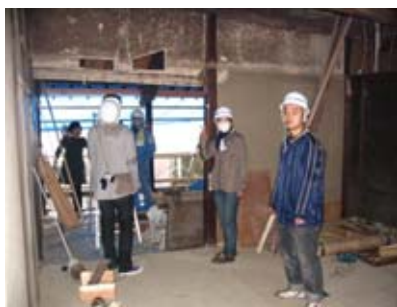
民家再生作業（右端院生）
