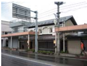
撤去を検討中のふれあい通アーケード
