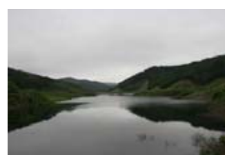
完成したおおのダム
