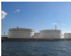
空いている石油タンク
