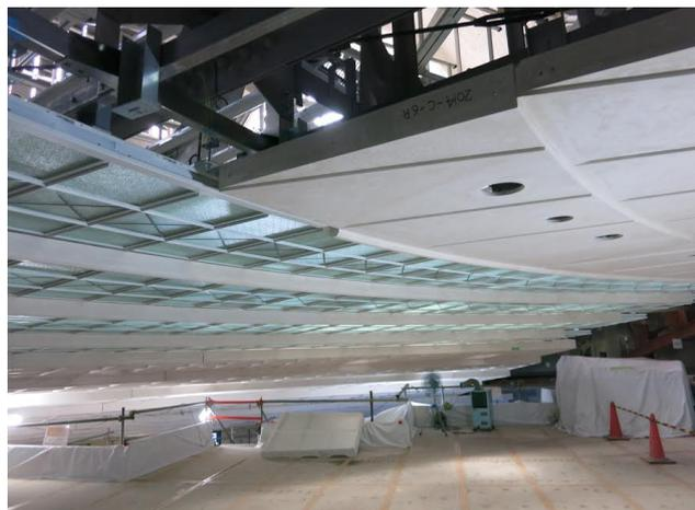
◀天井の新しい仕上がりが進む安田講堂。平米100kgだった漆喰仕上げの非常に重い天井を平米15kgの軽いGRCによる天井にやりかえているところ。(2014年7月29日撮影)
