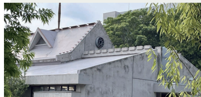
▲ ゴシック教会の丸窓のようなものを備えた象徴的な意匠（生態系研究フィールド 管理棟）
