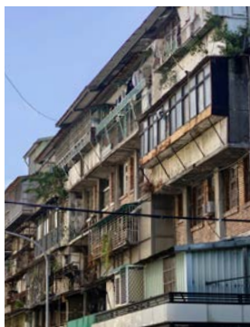
住民の工夫が詰まったファサード
