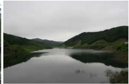
完成したおおのダム
