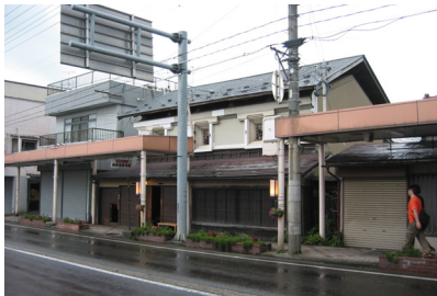
撤去を検討中のふれあい通アーケード
