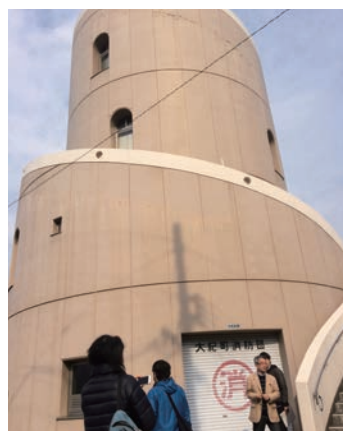
▲大紀町錦地区の避難タワーを見学
