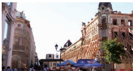
▲市中心部では歴史的建造物の修繕が進む
