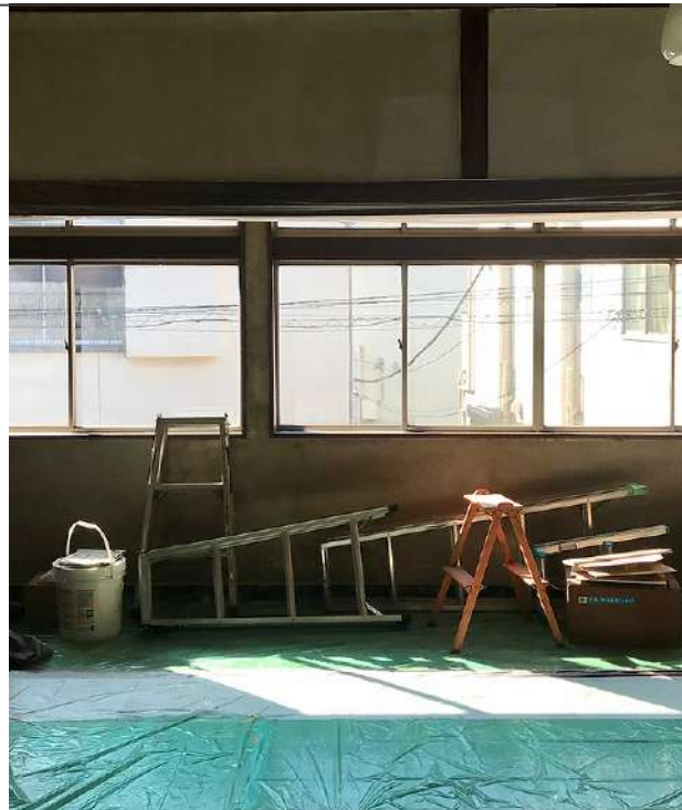
▲「せんつく本店」リノベーション工事の様子（足立区北千住） せんつく HP: https://www.sentsuku.com/ せんつくができるまで
