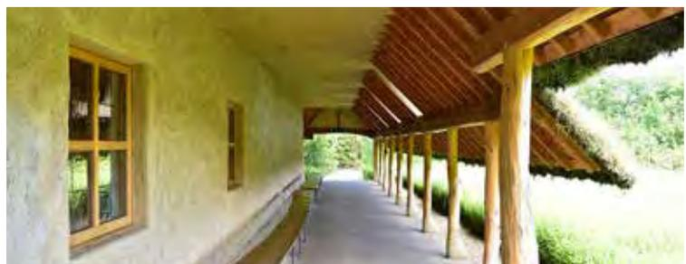
▲高さを抑え、クリの木を柱として用いた軒先
