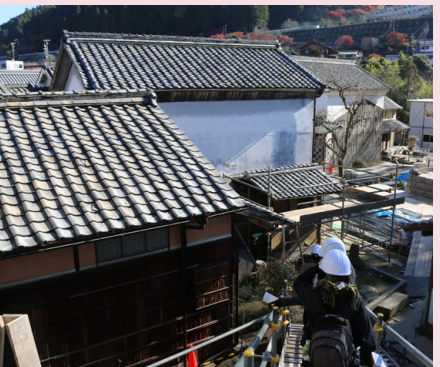
▲⑨ 改修中の紙屋邸(平成34年度完了予定)
